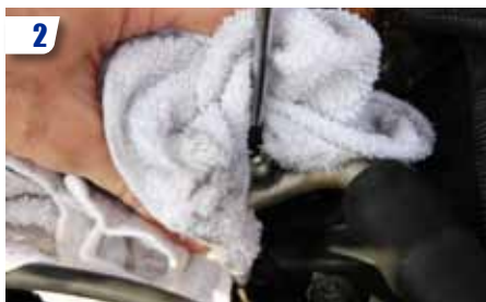
2 A ce stade, votre circuit de clim est vide. Néanmoins, par précaution, retirer les bouchons situés sur les durites et, à l'aide d'un tournevis, appuyer sur la valve afin de s'assurer que tout le gaz a bien été retiré. Attention : entourer la valve d'un chiffon pour éviter les projections.
