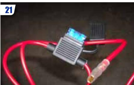
22 Confectionner le faisceau du circuit de puissance de la pompe.
