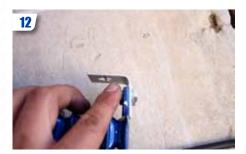
Fabriquer des platines qui permettront de le maintenir solidement. Le radiateur doit être fixé au moins à 3 endroits.
