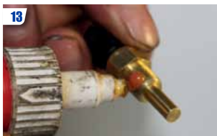
13 Installer la sonde de température d'eau sur le « T ». Utiliser de la pâte à joint sur le filet.
