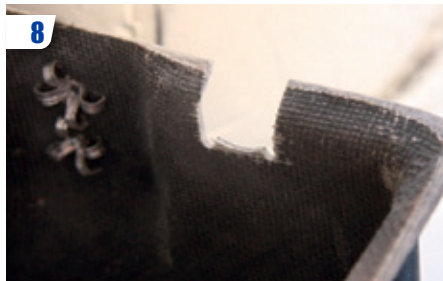
8 Découper une ou deux encoches pour le passage des câbles.
